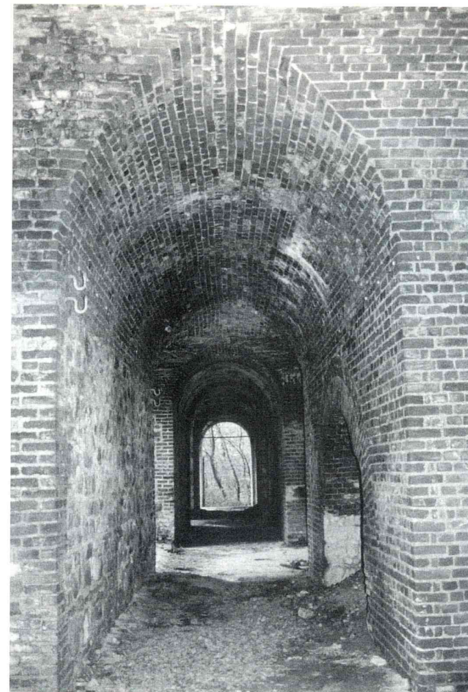
Die Öfen bestehen durchweg aus gut vermauertem Ziegelwerk. Die Anlage ist am Fuße ± 48 m lang und 16 m breit.
